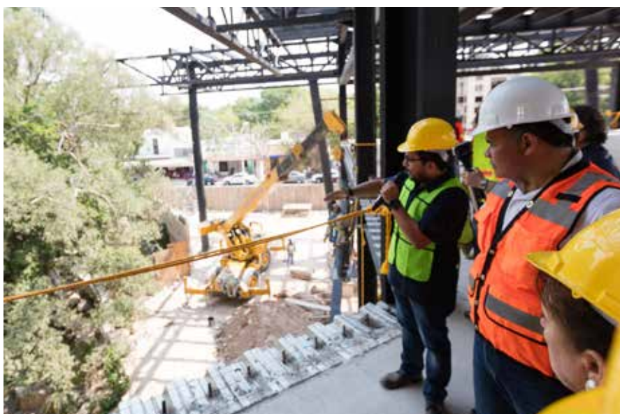
Para consolidar esta obra se emprendieron acciones de accesibilidad para que visitantes y locales puedan recorrer la zona de manera segura.
