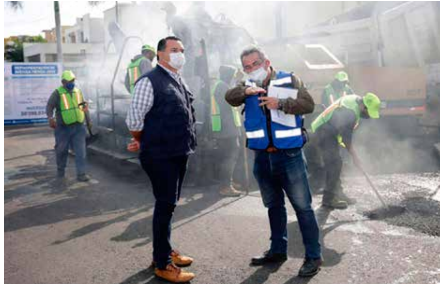
EL ALCALDE RENÁN BARRERA CONCHA SUPERVISÓ LAS LABORES DE REPAVIMENTACIÓN DE CALLES.
