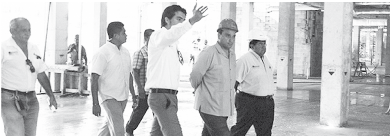
El nosocomio contará con 758 metros cuadrados adicionales a los programados en el proyecto inicial. En total el Hospital tendrá 7 mil 558 metros cuadrados de construcción.
