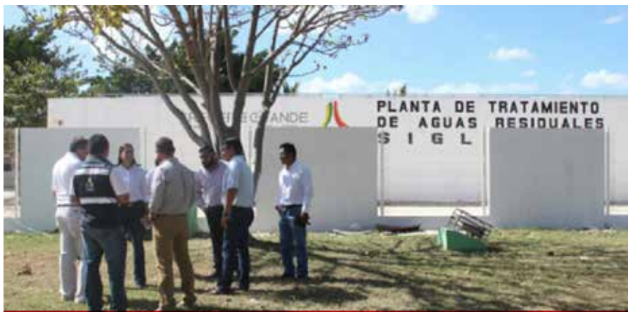
El gobernador Alejandro Moreno Cárdenas inauguró obras de drenaje pluvial y una planta de tratamiento de aguas residuales.
